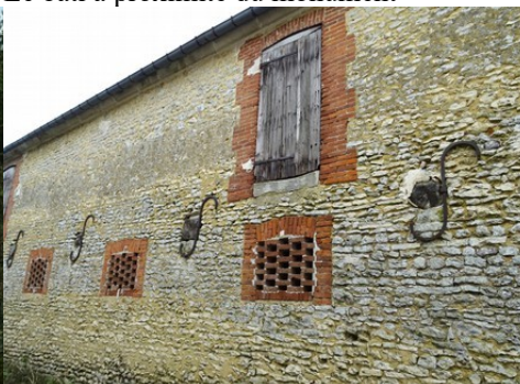
Le détail d'un mur en moellons
